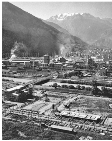
Abbildung 2: LONZA Visp um 1963 mit Cracker-Baustelle
